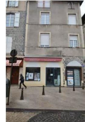
8, place de l'Hôtel de Ville. Façade de la seconde moitié du 12<sup>e</sup> siècle. Les cordons d'appui et l'arc du rez-de-chaussée suggèrent la présence des dispositions romanes aujourd'hui sous l'enduit de façade.
