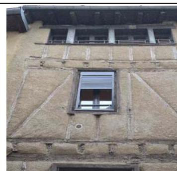
*La pose de volets roulants extérieurs à la place de « vrais » volets ouvrants s'accorde mal avec l'architecture classique de l'immeuble*
