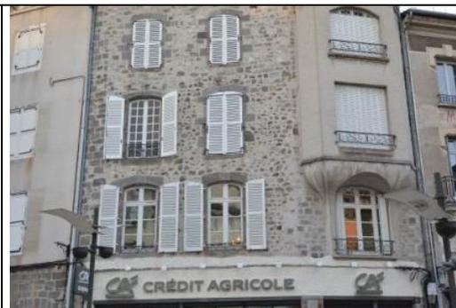
*La dégradation de l'unité architecturale des immeubles, par la disparité des menuiseries s'est généralisée sur une importante quantité d'immeubles. L'architecture classique est ordonnancée, les menuiseries doivent rester identiques.*
