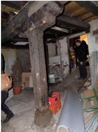
Rez-de-chaussée. Pilier à chapeau supportant une poutre maîtresse du plafond. Photo UDAP.
