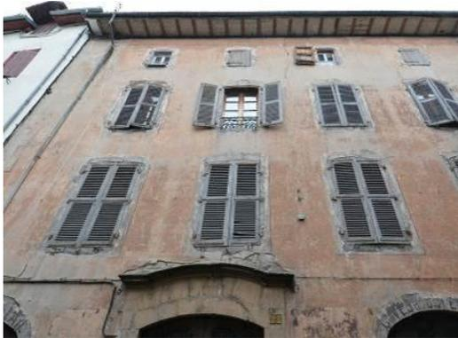
8, rue de la Bride. Façade d'un hôtel de la seconde moitié du 18<sup>e</sup> siècle. L'enduit qui couvre l'appareil en moellons favorise la mise en valeur, du portail, des devantures et des fenêtres.
