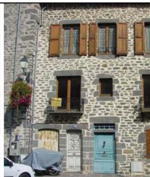
*Volets et fenêtres en bois naturels, au lieu d'être peints, fenêtre dont les carreaux n'ont pas été restitués, mise à nu des petites pierres, avec un jointoiement blanc, dénaturent l'aspect du bâti, en « morcelant » le traitement de façade de manière ostensible.*
