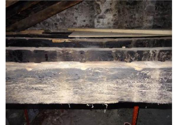
*Poutres du plafond du second étage (poutres de fortes sections et traces de couvre-joints).*
