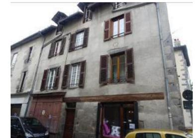
*19, rue du Buis. Façade en maçonnerie en rez-de-chaussée et au premier étage. Pan de bois aux niveaux supérieurs.*
