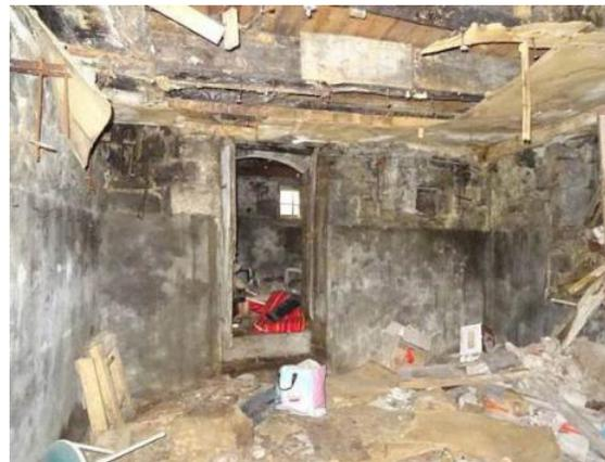
Rez-de-chaussée. Partie ouest. A gauche, étroite fenêtre romane couverte d'un arc en plein cintre. Au centre, porte du 18<sup>e</sup> siècle. A gauche, corbeaux en pierre pour poutre de rive de plancher.
