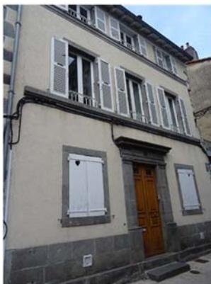
3, rue des Transparots. Façade en maçonnerie moellonnée enduite. Les registres des fenêtres sont soulignés par des cordons filant sur toute la largeur du mur.
