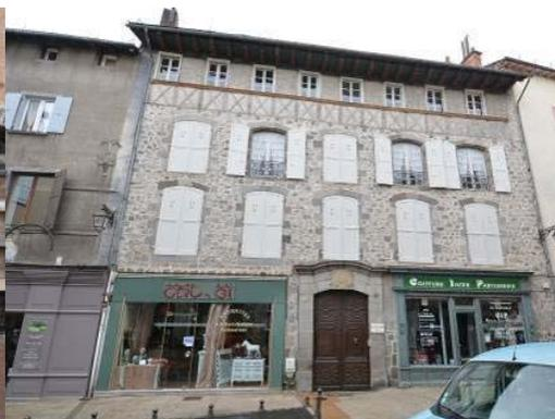
12, rue du Consulat. 1749. Façade en moellons après piquage de l'enduit. Le registre du comble en pan de bois en menuiserie devait être enduit ; seul le cordon d'appui en bois mouluré restant apparent.
