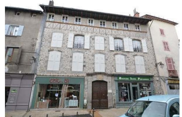
12, rue du Consulat. 1749. Maçonnerie moellonnée prévue pour recevoir un enduit.
