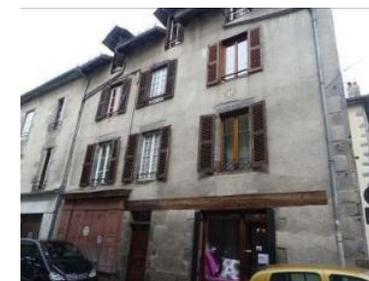
19, rue du Buis. Façade en maçonnerie en rez-de-chaussée et au premier étage. Pan de bois aux niveaux supérieurs.
