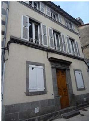
3, rue des Transparots. Façade en maçonnerie moellonnée enduite et soubassement en pierre de taille.
